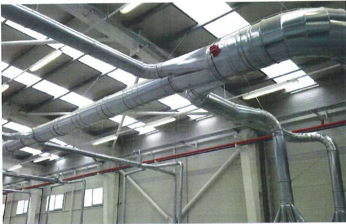
EXEMPLE D'INSTALLATION D'ASPIRATION POUR DÉCHETS DE BOIS
