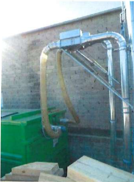
MINI-SILO FILTRANT ET SYSTÈME DE TRANSFERT PNEUMATIQUE DANS UN CONTENEUR FERME
