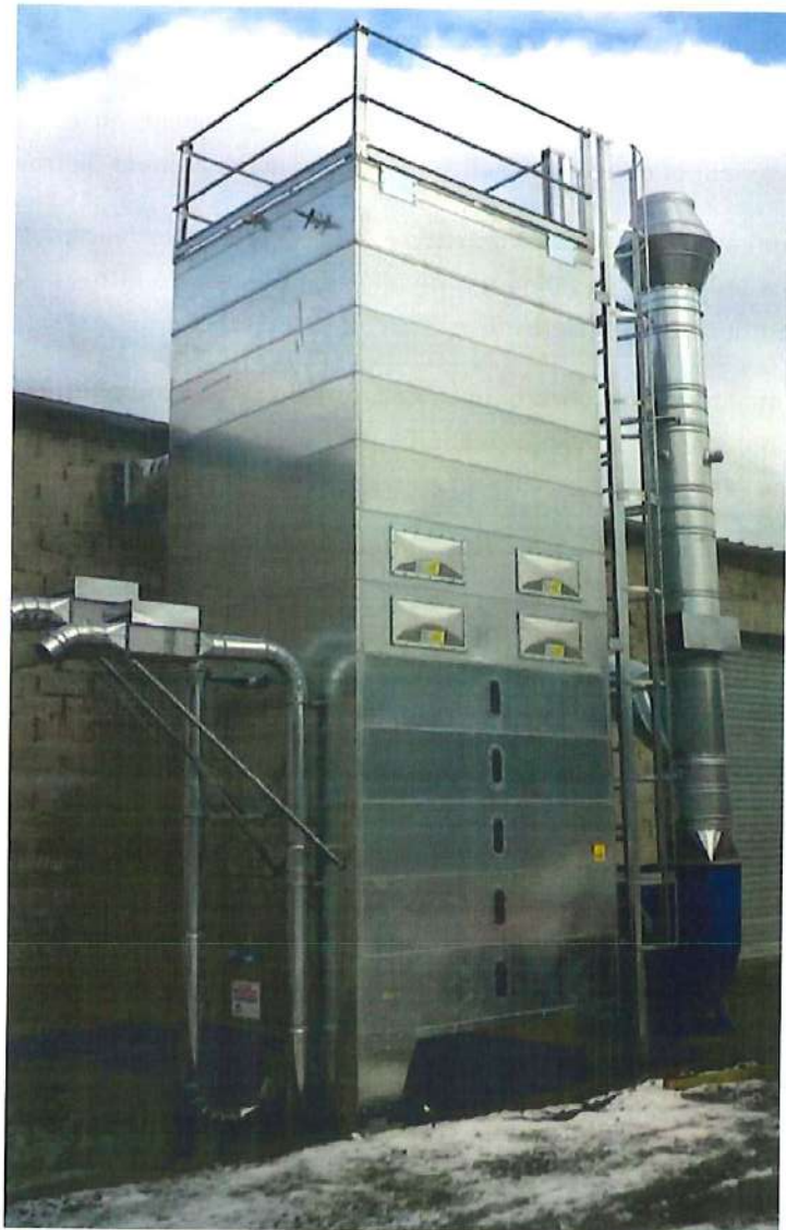
MINI-SILO FILTRANT ET SYSTÈME DE TRANSFERT PNEUMATIQUE DANS UN CONTENEUR FERME
